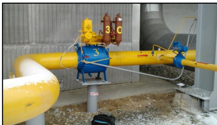
Рис. 2. Участок ТПО ГПА с угловым сварным соединением, по которому произошел отказ
