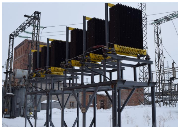
Рис. 5. Повреждаемость в сети 6 кВ мощной ТЭЦ (а) и фотографии установленных на ОРУ двух резисторов 300 Ом (б)
