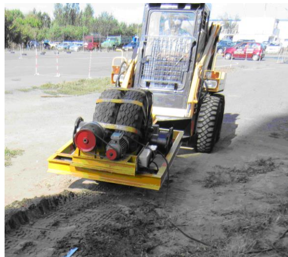
Рис. 2. Полевые испытания вибрационного пневмошинного катка при уплотнении супесчаного грунта
