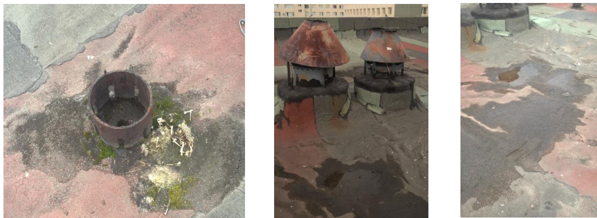
Рис. 2. Повреждения рулонной кровли
