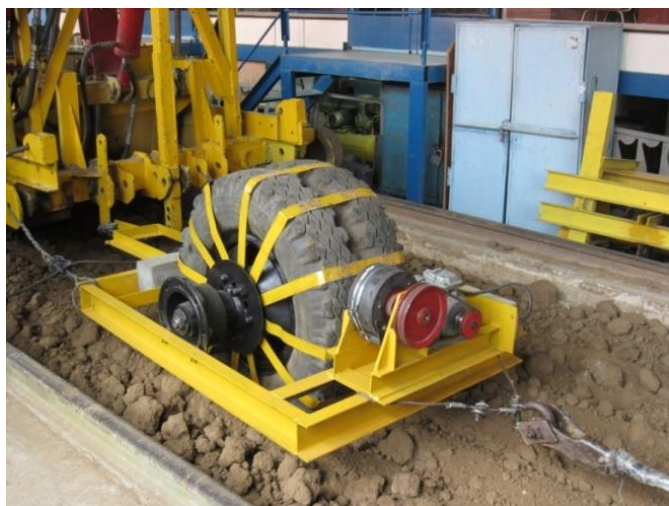
Рис. 1. Испытания вибрационного пневмошинного катка при уплотнении суглинистого грунта в грунтовом канале
