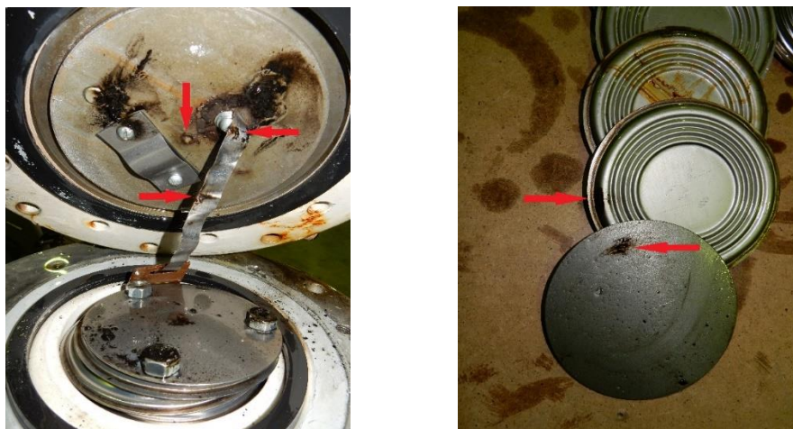
Рис. 9. Следы электрических (искровых) разрядов
