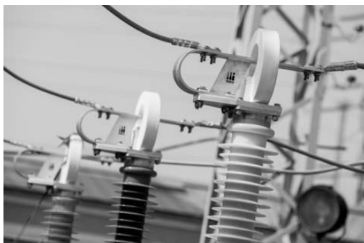
Рис. 1. Электронно-оптические трансформаторы тока
