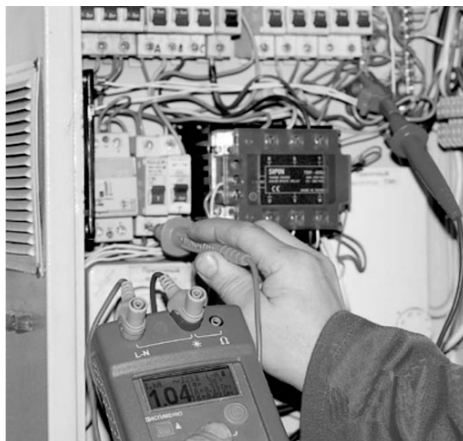
Рис. 1. Измерение сопротивления изоляции ОРУ
