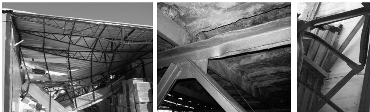
Рис. 1. Примеры обрушения и потери устойчивости стержней ферм
