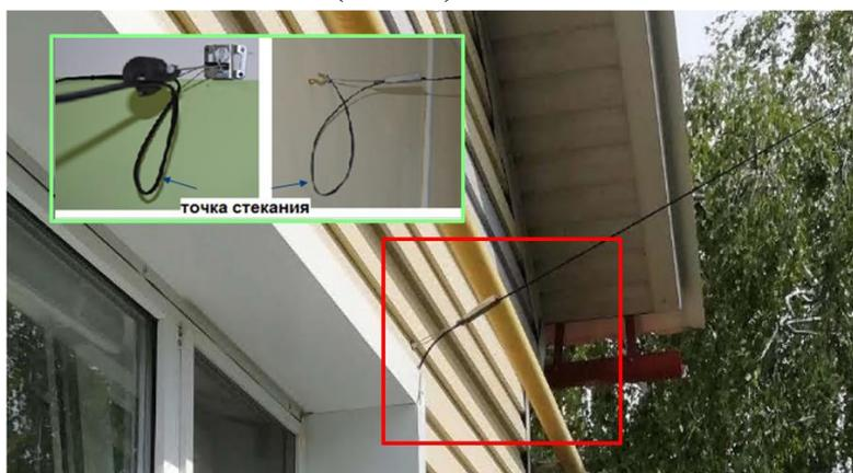
**Рис. 1. Иллюстрация нарушения монтажа кабеля**
